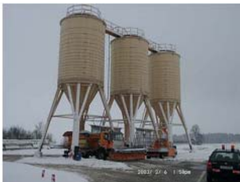
بهینه سازی زمان انجام عملیات راهداری زمستانی با استفاده از سیلوهای ذخیره سازی نمک
